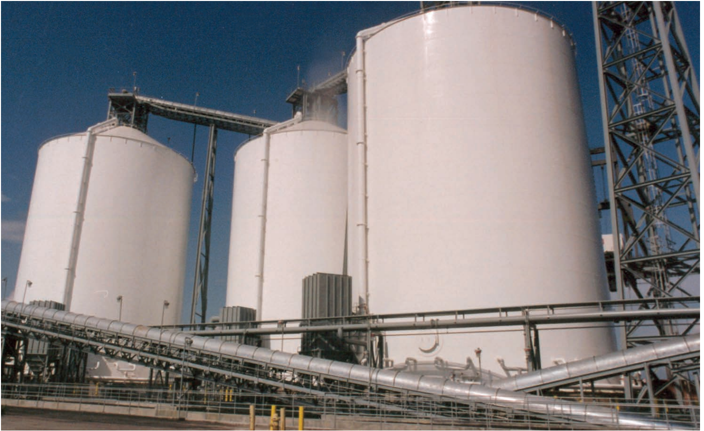
Transportador vertical Airlift™ con un sistema de transporte por gravedad Airslide®
