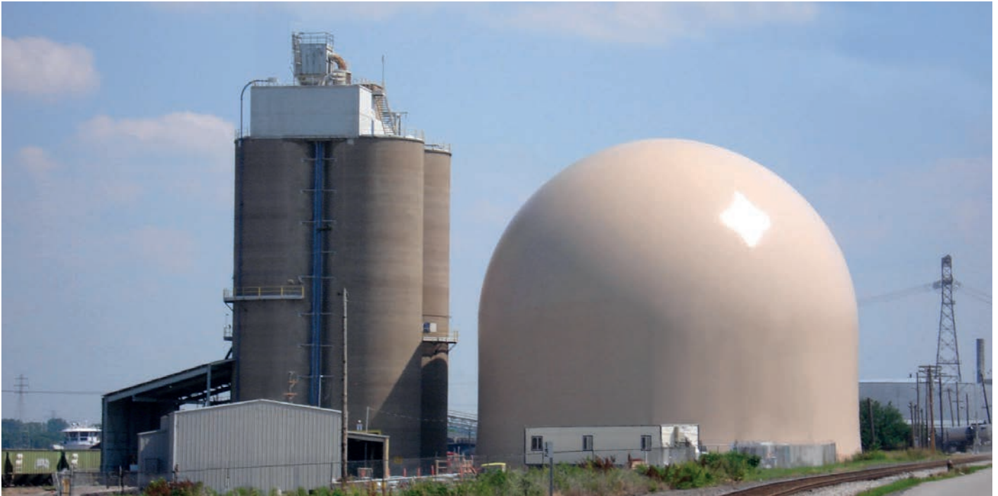
Domo de almacenamiento
