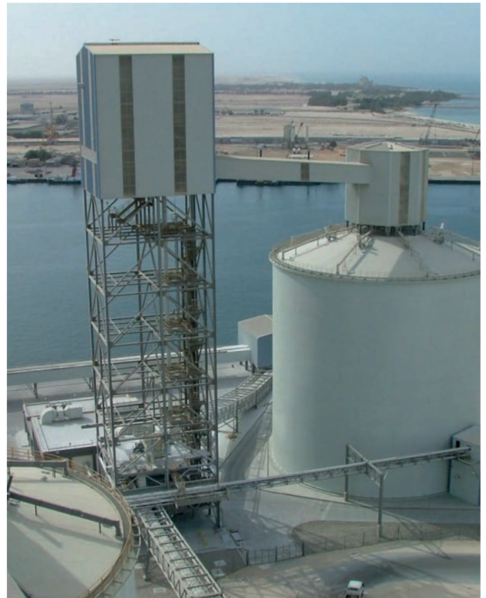
Transportador Airlift™ para transporte neumático vertical
